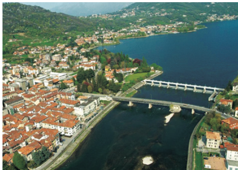
Vista aerea della diga e del ponte di Olginate. (Foto di Giovanni Peverelli)
