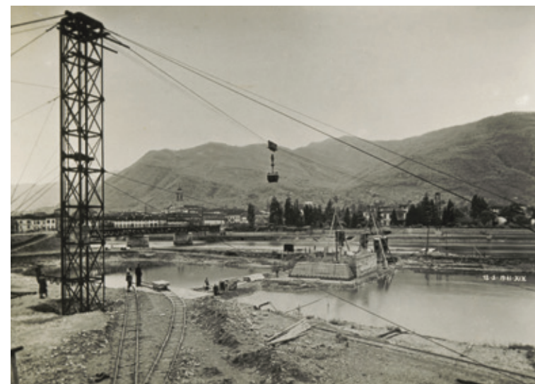
Diga in costruzione, anno 1943. (Consorzio dell'Adda - Milano)
